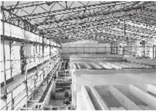
Um während der Bauzeit Wassereintritt in den Bestand zu verhindern, mussten die Zeilenbauten eingehaust werden. Dies erschwerte die Montage der Holztafelelemente.
