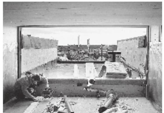
Während der oberste Dachaustritt beidseitig von Brettschichtholzüberzügen flankiert wird, geht der Wohnraum im zweiten Dachgeschoss stützenfrei in die Dachterrasse über.
